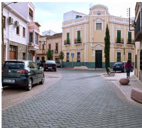
FIGURAS 144 y 145: Adoquín prefabricado de hormigón. Fuente: [www.prefabricadosroda.com](http://www.prefabricadosroda.com)
