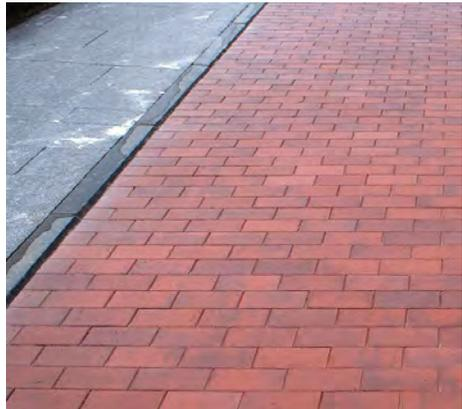
FIGURA 142: Baldosa hormigón prefabricado. FIGURA 143: Adoquín hormigón prefabricado. Fuente: [www.pvt.es](http://www.pvt.es).
