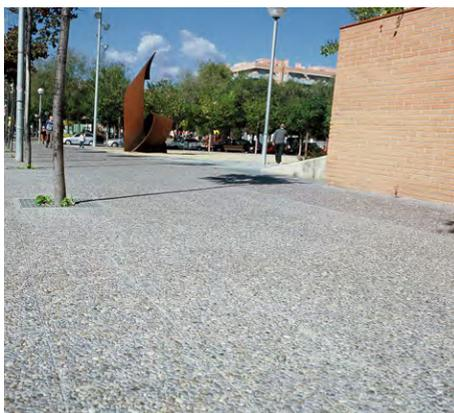
FIGURA 81: Pavimento terrazo relieve. FIGURA 82: Pavimento terrazo canto o china lavada. Fuente: [www.prefabricatslomar.com](http://www.prefabricatslomar.com).
