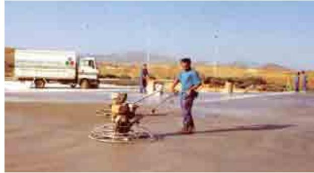
migón, a continuación se realiza el espolvoreo del agregado mineral y se fratasas, la aplicación del líquido de curado se hará lo más pronto posible, y se procede al corte de junta de dilatación y retracción.
