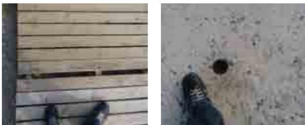
**Figuras 21 y 22.** Deterioro del pavimento de madera en accesos a la playa y orificios en el pavimento de hormigón de los espigones.
