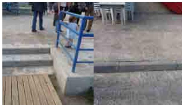
**Fig. 14.** Falta de pavimentos señalizadores y de orientación
