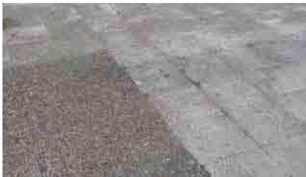
Fig. 16. Aspecto del pavimento de hormigón con árido visto en el paseo.
