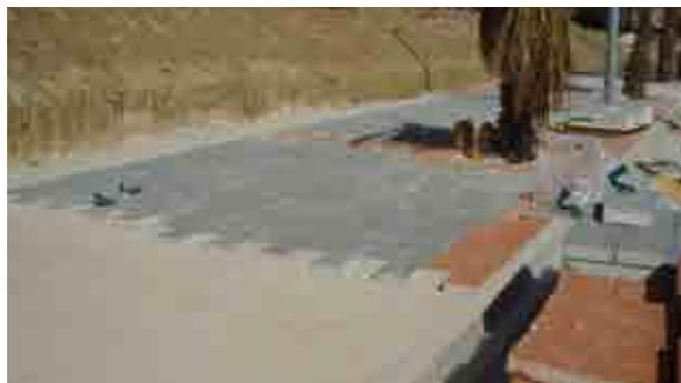
Sus patologías más significativas pueden ser ondulaciones de la superficie, desprendimiento de adoquines y rotura de los mismos.
