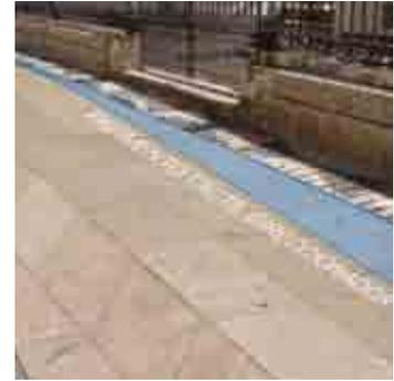
La sustitución del adoquinado se realiza por piezas de piedra de mayores dimensiones, con el objeto de reducir el número de juntas.
