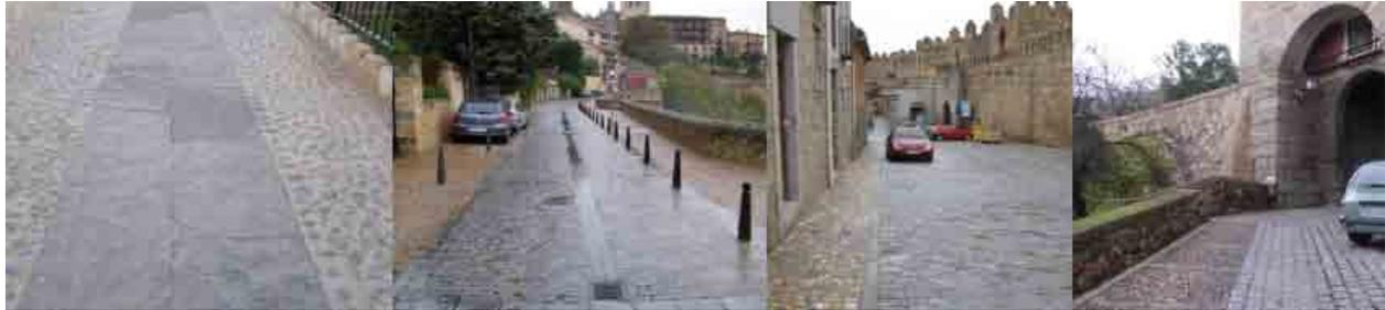
canaleta central de recogida de aguas se ejecuta con canto rodado y la zona transitable de piezas lisas, parece una solución más adecuada, a cuando se coloca la parte de la canaleta central lisa y el peatón acaba usándola de zona de paso, aunque se encuentre algo húmeda.
