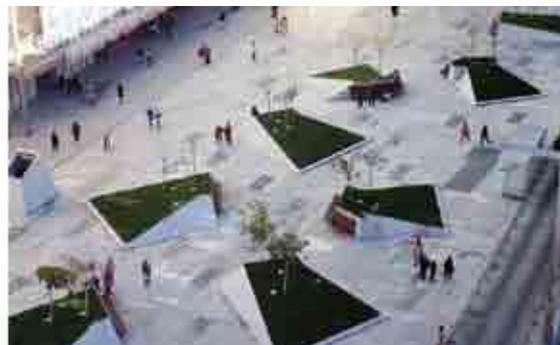
El pavimento está definido por losas de granito de diferentes dimensiones y texturas según se define el uso del espacio. En el área estancial, las losas de granito se intercalan con otras de fundición de bronce, que incorporan escultura en bajo relieve. Cada 5 m., se dispone una junta formada por una línea continua de leds que dota al conjunto de un nuevo orden geométrico y de mayor riqueza visual.
