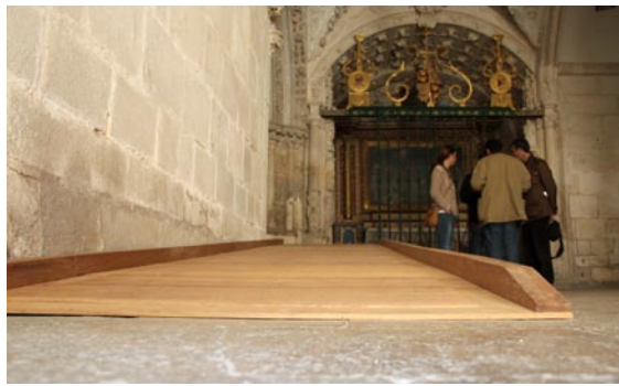
Rampa antideslizante con protección lateral.
