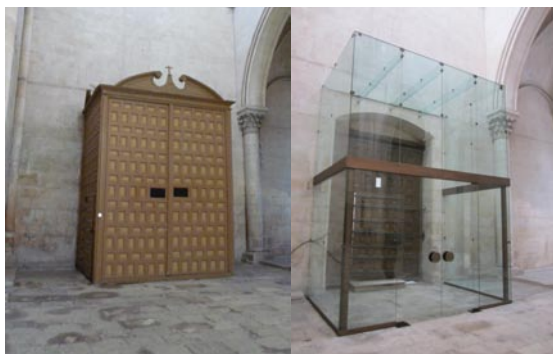
Antes y después de sustituir la puerta de madera por un cortaviento de vidrio en el Monasterio de las Huelgas.
