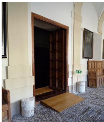
Rampa colocada en el Monasterio de Tordesillas.
