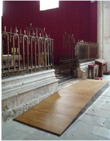
Rampa de acceso al altar de la iglesia.
