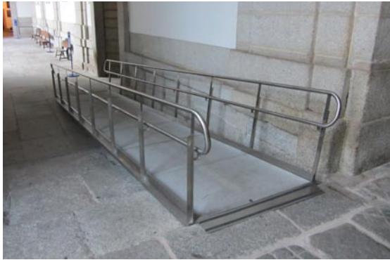
Actuación en el Patio del Abrevadero. Rampa.
