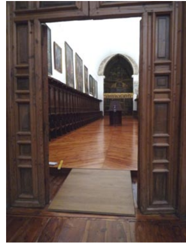
Detalle de rampa móvil para permitir el cierre de puertas.
