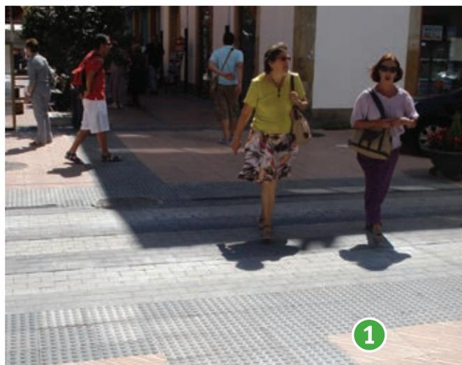
① Vado de peatones sin rebaje, señalado con franja transversal de aviso de textura punteada situada en el eje del mismo y perpendicular al sentido de circulación
