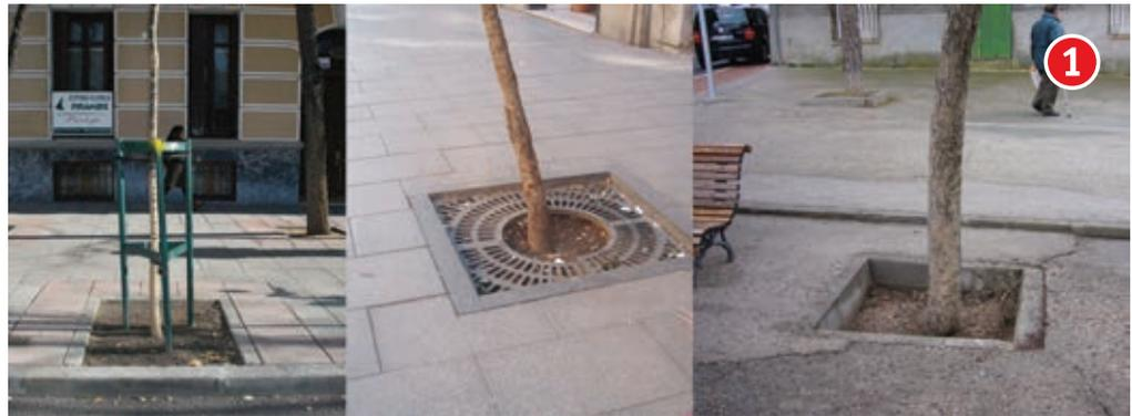
① Diversos ejemplos de alcorques sin protección o con protección inadecuada, que pueden generar tropiezos y caídas.
