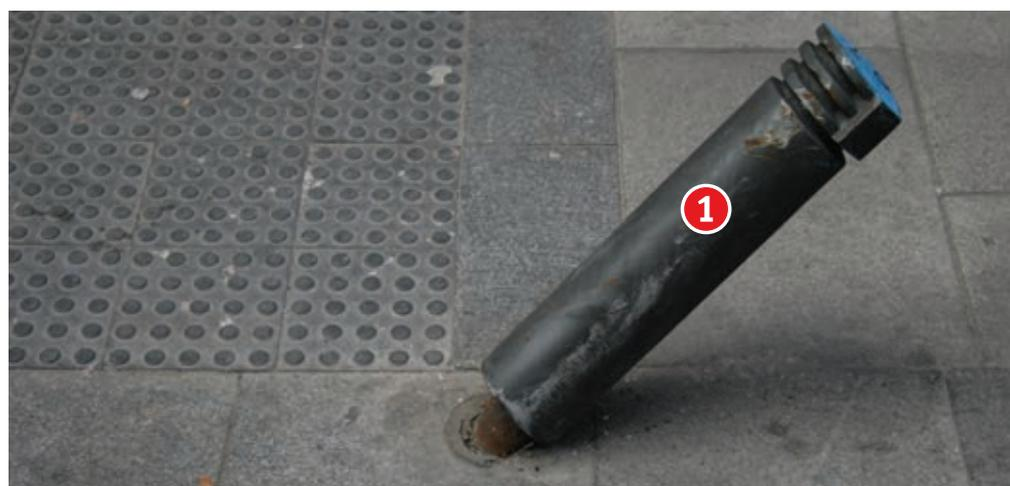
① Bolardo con altura insuficiente para su fácil detección y mal anclado.
