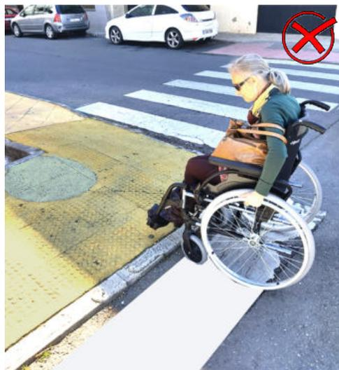
Pavimentos enrasados o con un resalte inferior de 4mm
