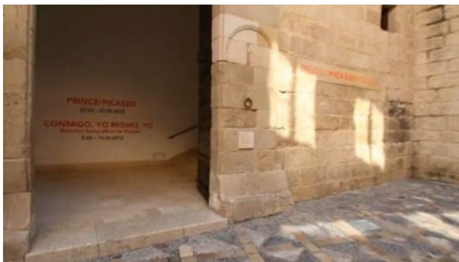
Puerta principal de MPM y escalinatas de acceso. Autoría: C. Serrano.
