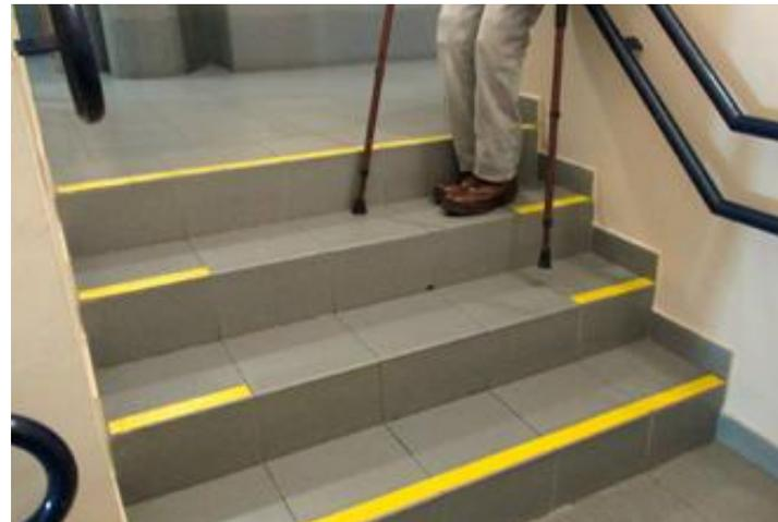
**01** Cada llegada al tramo de escaleras tendrá un **elemento señalizador**, detectable por personas con dificultad de visión, mediante banda de pavimento de color, textura y tacto diferente del resto, adosada al primer peldaño.
