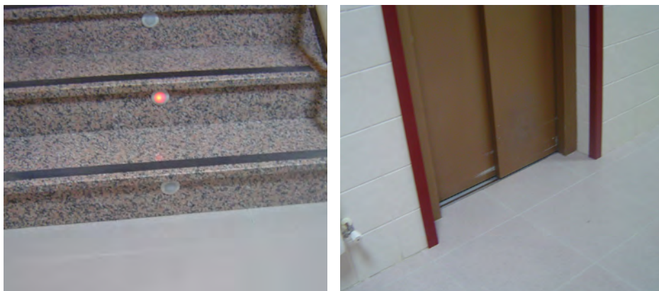
Imágenes 201 y 202. Primer escalón de subida a primera planta para señalar (dormitorios de mujeres y texto ascensor plantas baja y primera).
