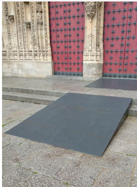
Rampa postiza, colocada sobre el pavimento existente, en chapa de acero muy deslizante en mojado. Casco Histórico de Salamanca.
