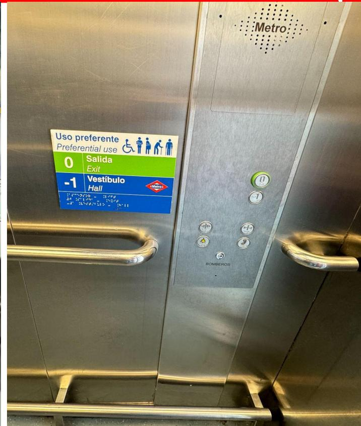
Cabina con intercomunicador, botonerías adecuadas (altura, altorrelieve y braille) y panel señalizador en altorrelieve y braille. Ascensor exterior. Metro de Madrid.
